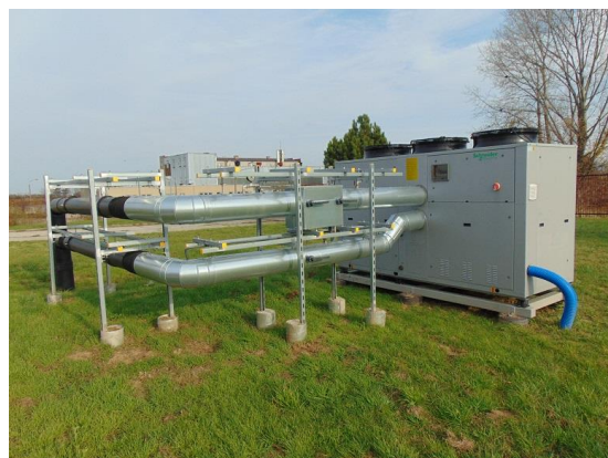
Agregat wody lodowej dla pawilonu
